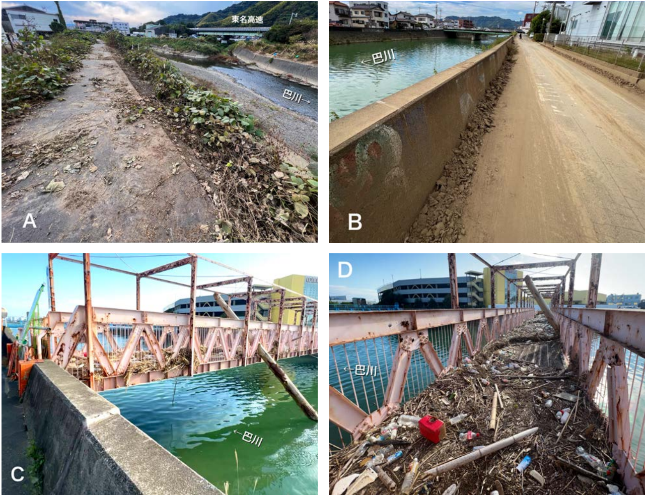
図10 巴川本流の越流箇所例。A：堤防上の泥痕や草の倒れ方から越流が確認できる例（清水区長崎，2022年11月17日撮影，位置は図14），B：堤防上や側道の泥痕から越流が確認できる例（清水区江尻台，2022年10月3日撮影，位置は図11A），C・D：歩道橋上の流水木や浮遊ゴミの堆積状況によって側道への越流が確認できる例（清水区江尻台，2022年11月4日撮影，位置は図11A）。この橋は老朽化によって2018年1月～2019年7月のどこかの時点で通行止めとされていたことがGoogleストリートビューによって確認できる。
