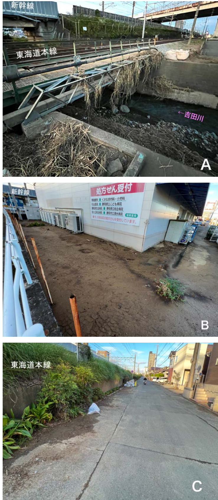
図20 有度丘陵北縁（吉田川）の浸水被害の例（位置は図18A, 19）。A：JR東海道本線の橋梁手前での吉田川の越流点（駿河区中吉田，2022年10月1日撮影）。橋梁下の河道断面積が不足したため越流とみられる。B：JR東海道本線の中吉田踏切わきの店舗の浸水被害（駿河区中吉田，2022年10月10日撮影）。A図の地点での越流が原因とみられる。C：東海道本線の盛土に沿った浸水被害（清水区中之郷，2022年10月10日撮影）。A図の地点での越流が達した低標高部にあたる。
